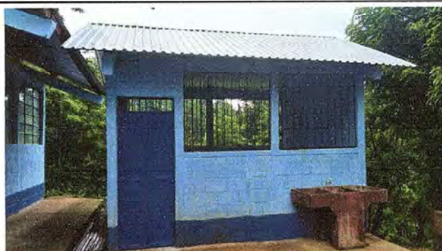
Foto 3: SUSTITUCION DE VENTANA DE COCINA
