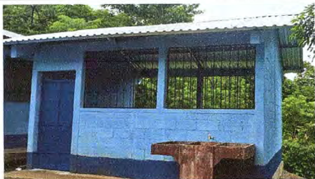
Foto 1: Proyecto final de cocina en donde se puede observar colocación de balcones, reparación de paredes, cambio de techo, cambio de puerta
