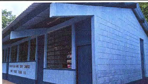
Foto 6: SUSTITUCION DE PUERTAS DEL ESTABLECIMIENTO
