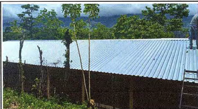
Foto 4: SUSTITUCION DE TECHO DEL ESTABLECIMIENTO
